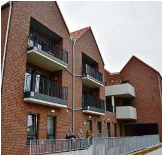
Über 20 barrierefreie Wohnungen und eine Wohngemeinschaft verfügt die Senioren-Wohnanlage Dorf-Mitte in Lette. Fotos: lem
