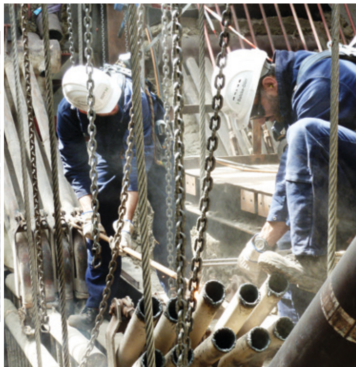
Ein Drahtseilakt: Ausheben eines Bündels über das Kesseldach
