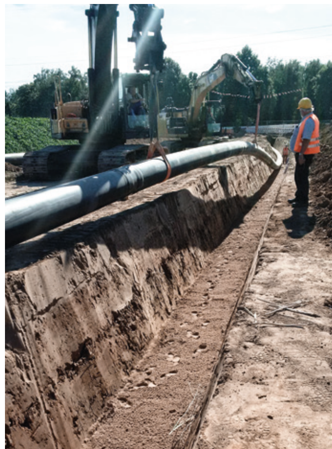
Einheben der neuen Leitung
