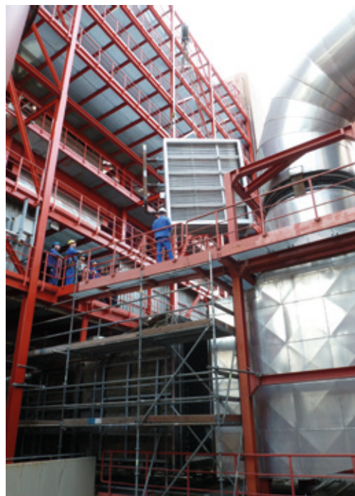
Revisionsarbeiten: Einheben eines neuen Dampfgasvorwärmers
