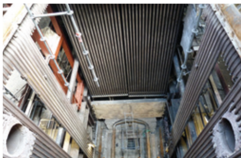
Aufbau der Kesselseitenwände
