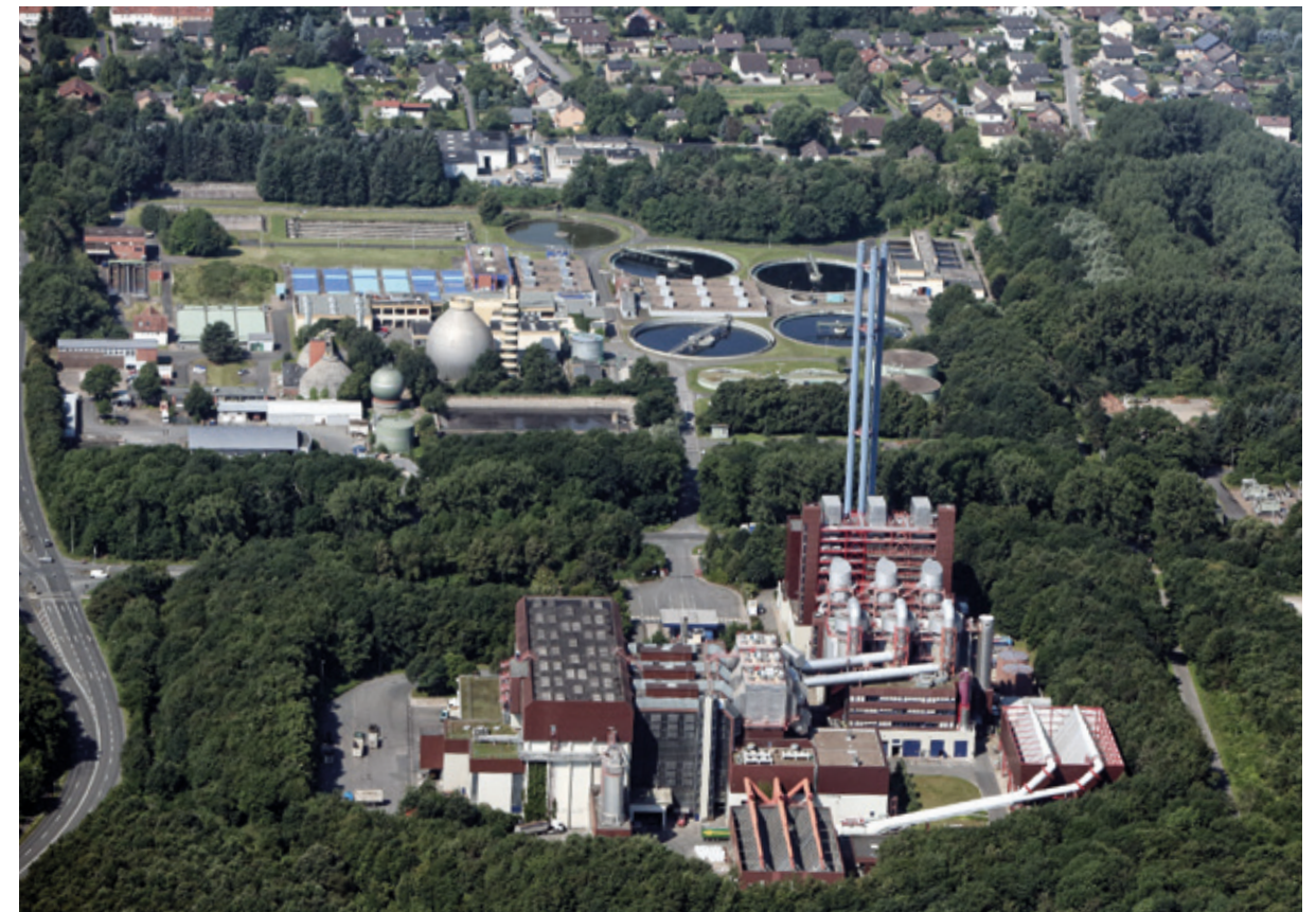
MVA und Kläranlage in direkter Nachbarschaft am Schelpmilser Weg
