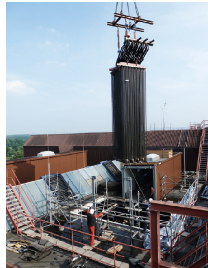
Einheben eines neuen Kesselrohrbündels
