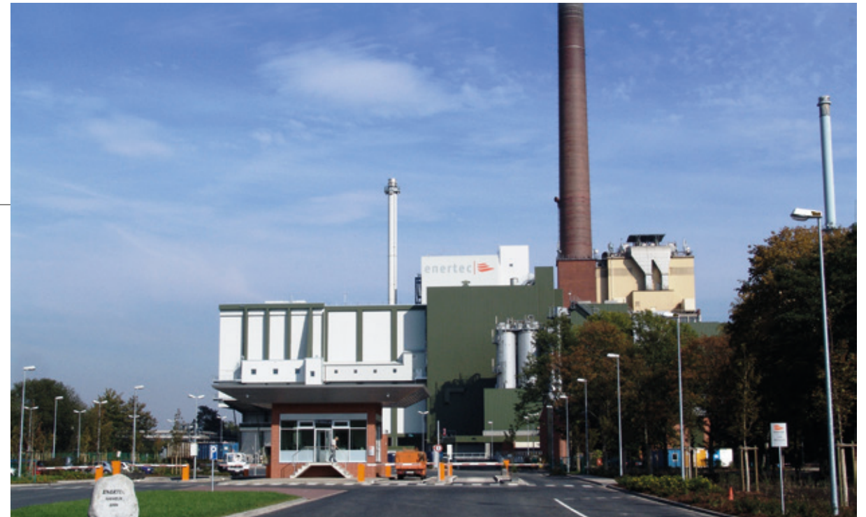
Außenansicht der Enertec Hameln
