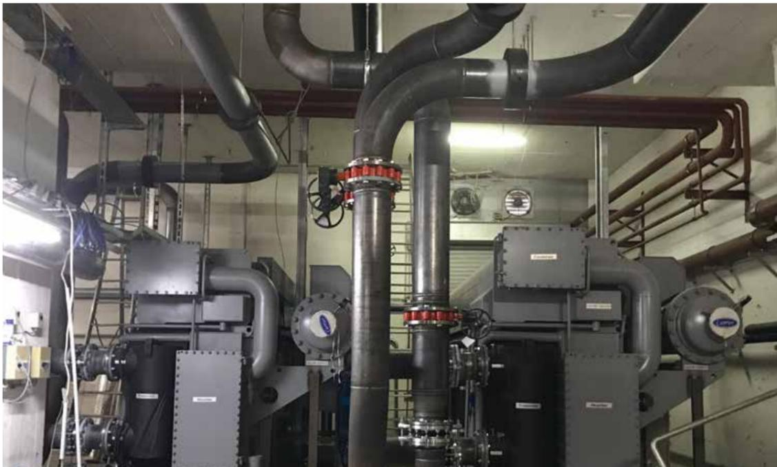
Neu installierte Kälteanlagen im BHW-Gebäude für eine bessere Steuerung des Kältebedarfs in den Unternehmensräumen und Rechenzentren
