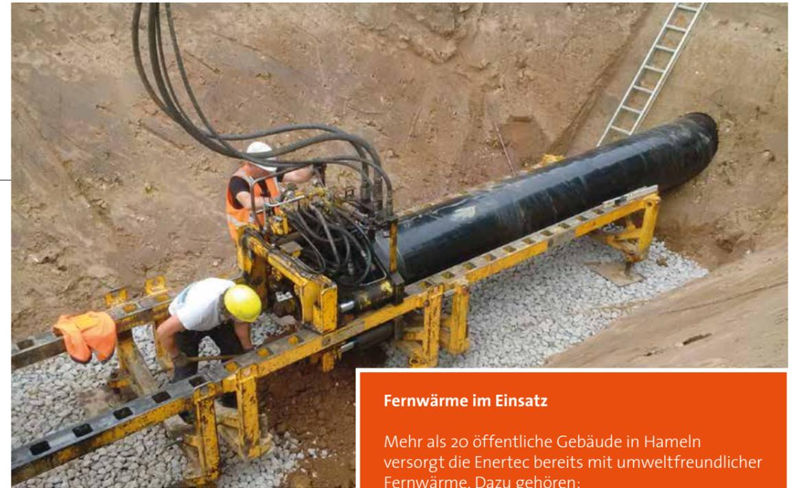
Ausbau des Fernwärmenetzes in Hameln: Durchpressen einer Rohrleitung unterhalb einer Straße
