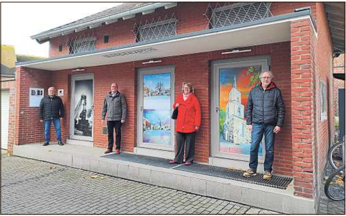
Christa Schwab und Alois Steinkamp vom Ahlener Verein für Städtepartnerschaft sowie Christoph Wessels (Stadt Ahlen) freuen sich mit Thorsten Hatton von den Stadtwerken über die neue Gestaltung der Trafostation, gewidmet der Partnerstadt Teltow. Das Foto zeigt (v. l.) Steinkamp, Hatton Schwab und Wessels. Foto: Stadtwerke
