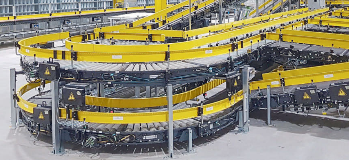
Samont installiert komplexe Fördertechnik für große Logistikzentren im In- und Ausland.
