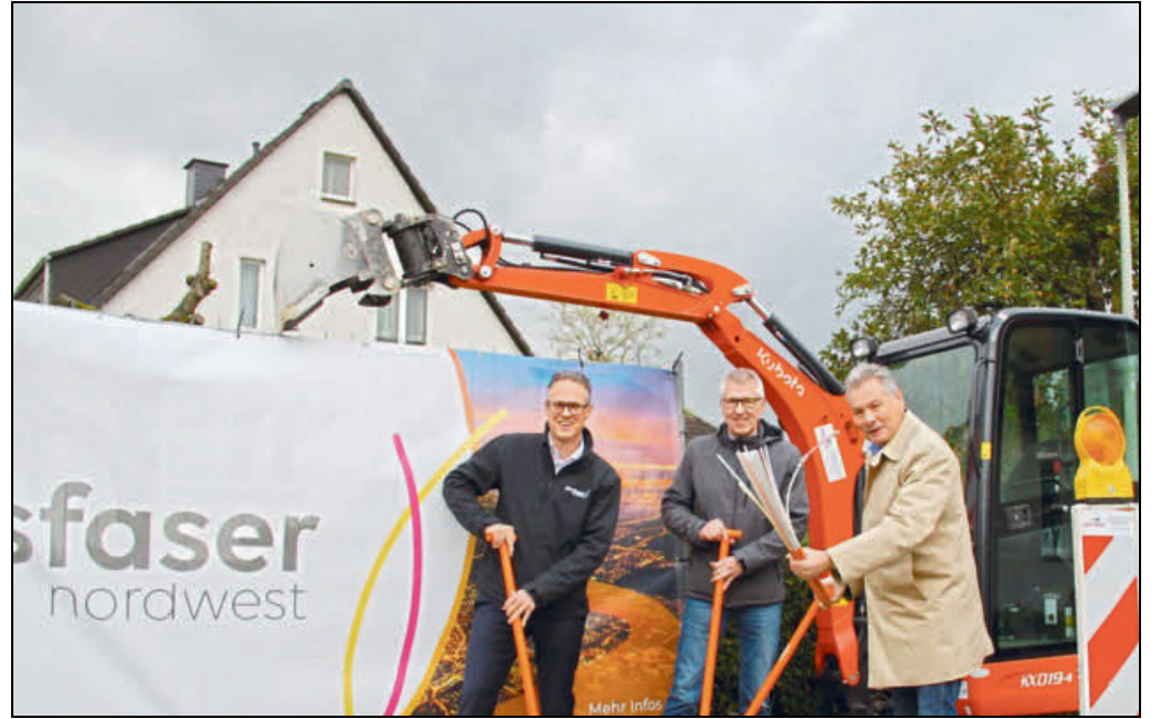
Es kann losgehen im Paderborner Nordosten: Andreas Mayer (Geschäftsführer Glasfaser Nordwest), Projektleiter Karl-Heinz Wintermeyer (Deutsche Telekom Technik) und Paderborns stellvertretender Bürgermeister Dietrich Honervogt beim Spatenstich für das neue Glasfasernetz. Foto: Kerstin Eigendorf
