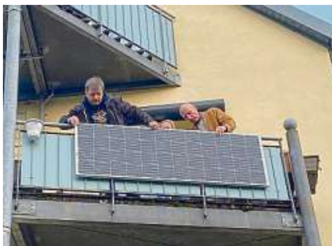
Auch an Balkonen lassen sich Stecker-Solaranlagen anbringen. Foto: DGS NRW
