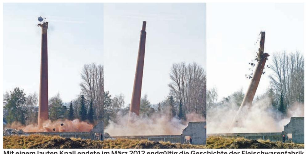
Mit einem lauten Knall endete im März 2012 endgültig die Geschichte der Fleischwarenfabrik Landwehr, als der 36 Meter hohe Landwehr-Schornstein mit 3,5 Kilo Sprengstoff zu Fall gebracht wurde. Foto: wi
