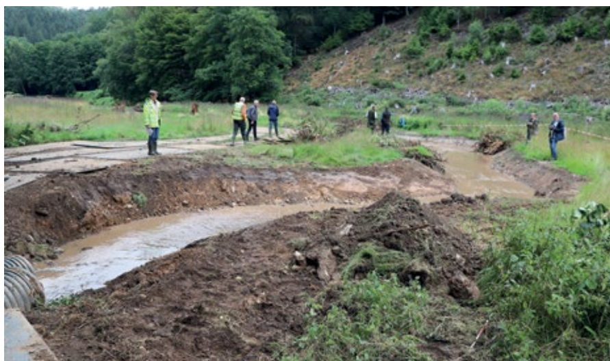
Die Heilenbecke, wenige Minuten nach der Umlegung in ihr neues Bett
