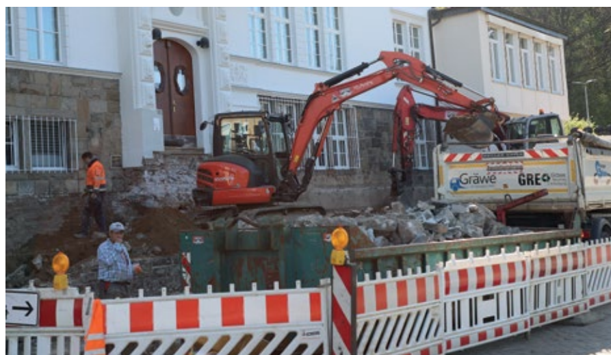
Abbruch der Stützmauer am Rathaus-Altbau
