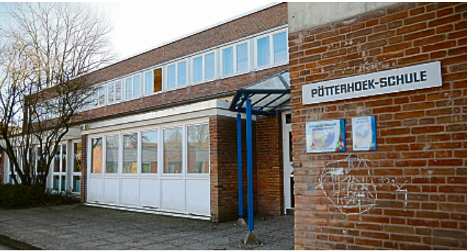
Zu den Sofortmaßnahmen für den Klimaschutz gehört auch die energetischen Sanierung der Pötterhoekschule. Foto: Oliver Werner
