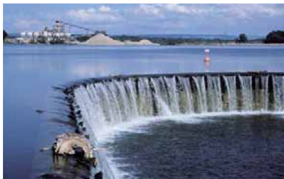
Das alte Auslaufbauwerk des Lippesees – ein Hindernis für Wassertiere
