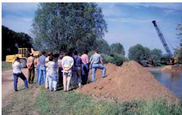
Baumaßnahmen sind spannend: Lippe und Aue werden mit dem Bagger in einen guten Startzustand für die natürliche Weiterentwicklung versetzt.
