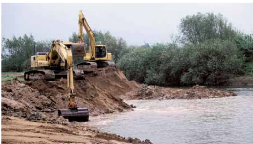
Bagger gestalten das neue Lippeaufer
