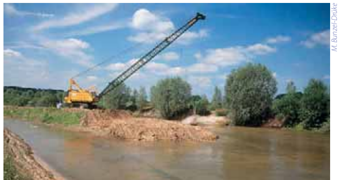
Der Seilzugbagger füllt Sand vom Mitteldamm in das alte Bett der Lippe. Links liegt der Verbreiterungsgraben, der im Vordergrund schon Teil der neuen, breiten Lippe ist.
