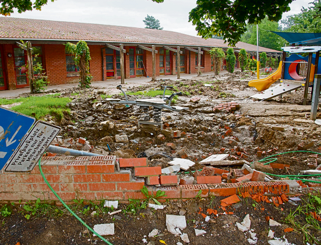
Bad Neuenahr-Ahrweiler ist von der Hochwasserkatastrophe stark betroffen. Die Aufbauarbeiten werden noch lange dauern, weitere Unterstützung ist dabei sicher willkommen. Foto: Gunnar A. Pier
