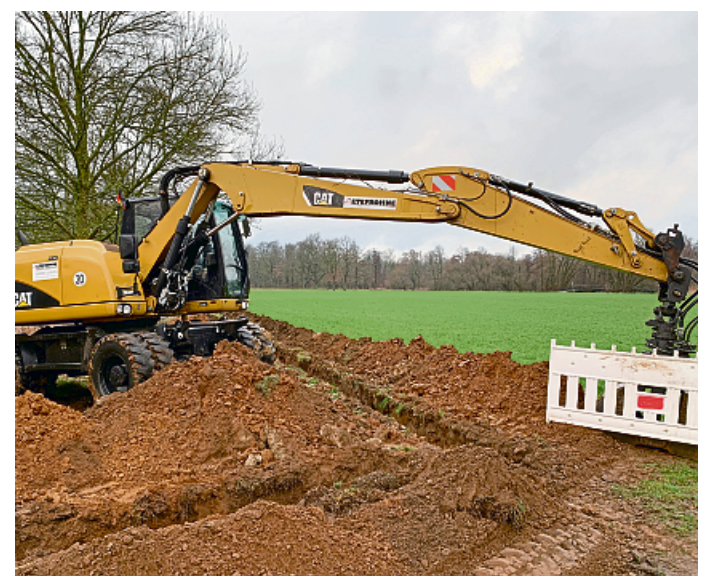
In den Emsauen in der Nähe der Firma Kraege führen die Stadtwerke aktuell Tiefbauarbeiten durch. Dort entsteht eine neue Mittelspannungstrasse, die die vorhandenen Freileitungen ersetzen soll. Foto: Große Hüttmann
