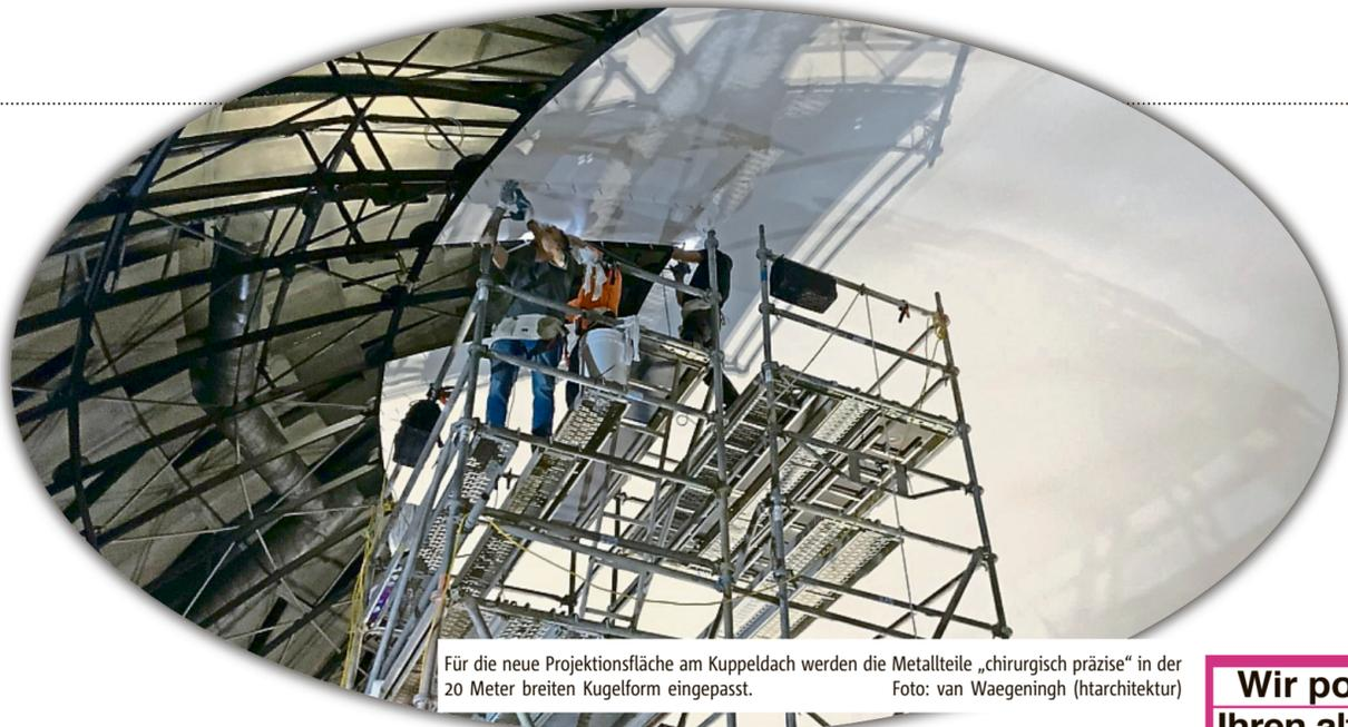
Für die neue Projektionsfläche am Kuppeldach werden die Metallteile „chirurgisch präzise“ in der 20 Meter breiten Kugelform eingepasst. Foto: van Waegeningh (tarchitektur)
