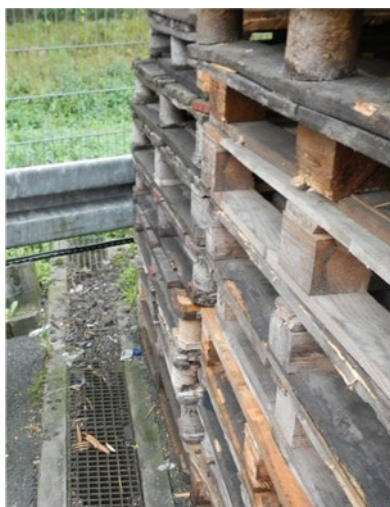
Abbildung 24 & 25: Ablagerungen auf Kastenrinne (links) und leichte Sedimentbildung in Kastenrinne (rechts) als potentieller Ausgangspunkt für Wulstbildung und Graseinwuchs
