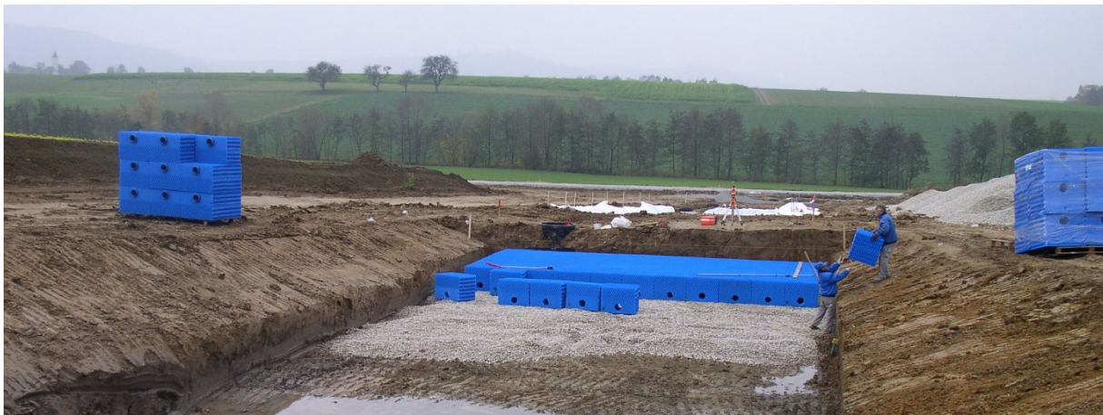
Abbildung 76: Einbringen von Füllkörperrigolen auf einer Sauberkeitsschicht
