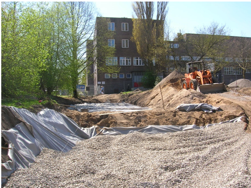
Abbildung 76: Einbringen von Füllkörperrigolen auf einer Sauberkeitsschicht
