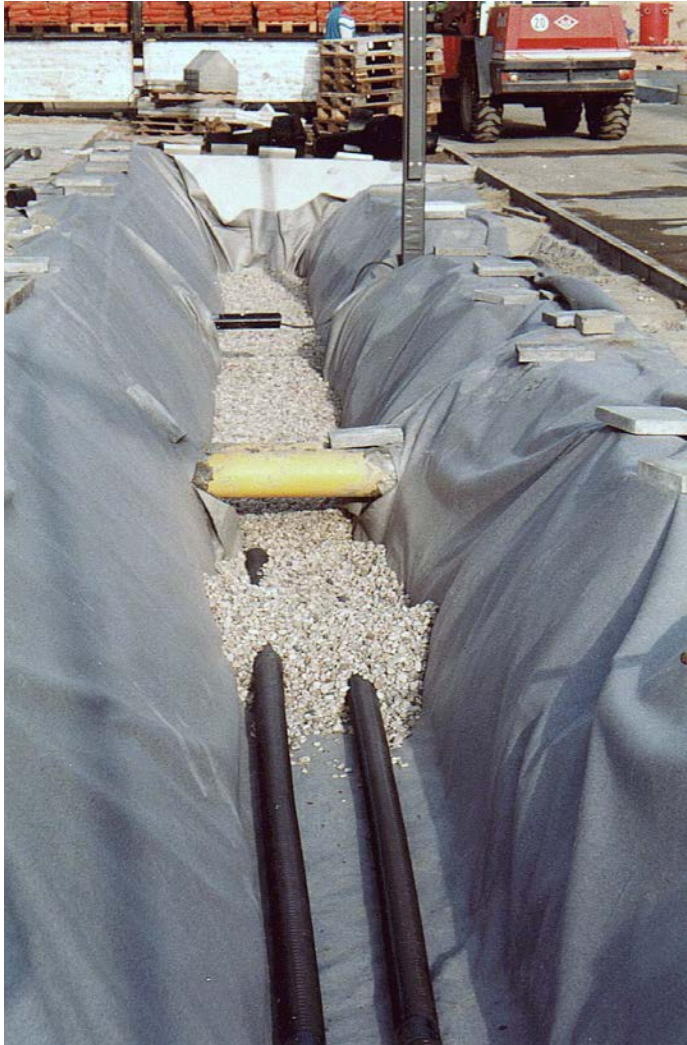
Abbildung 75: Einbringen des Geotextils unter Vorhaltung ausreichender Überlappungsbereiche
