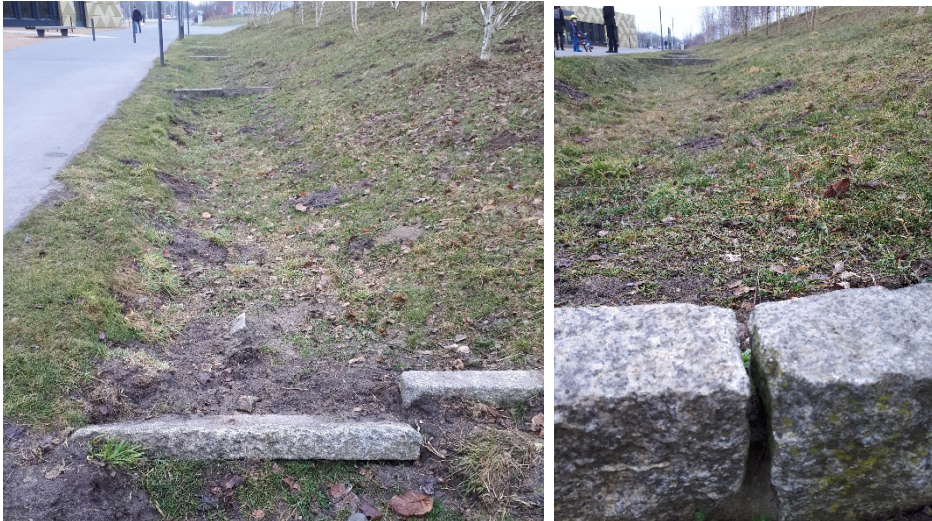
Abbildungen 71 & 72: Unplanmäßiger Überlauf durch beschädigte Kaskadensteine (links) und Ausspülung der Fugen (rechts).
