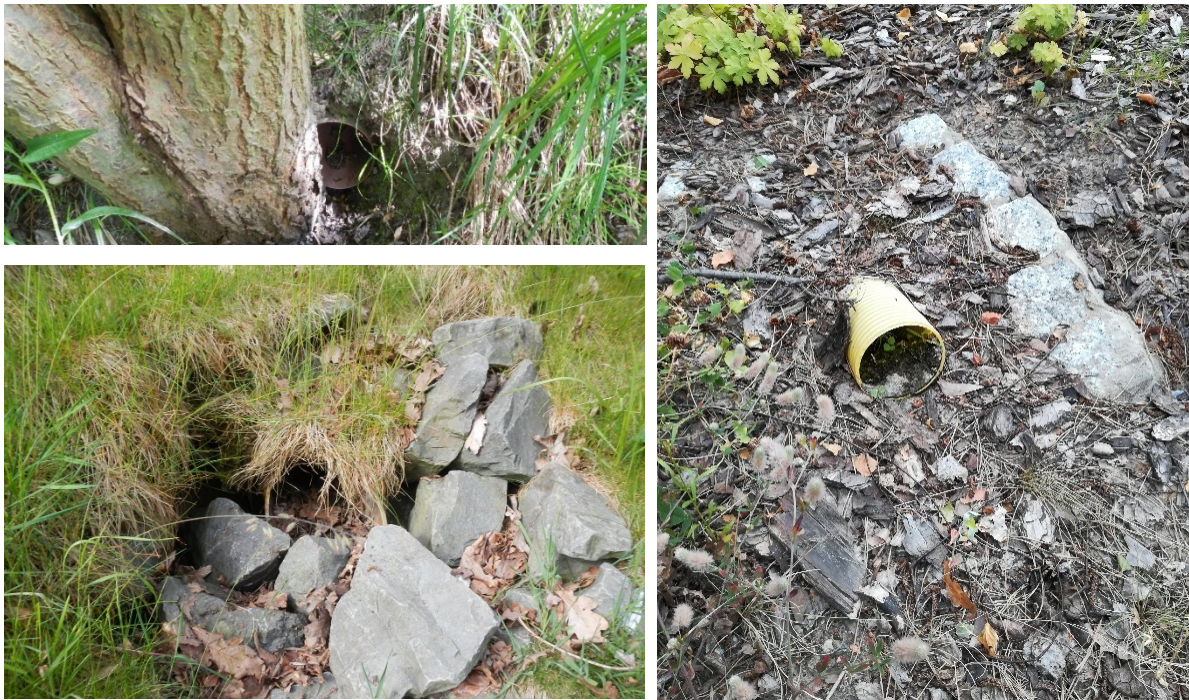
Abbildung 58, 59 & 60: Gehölzaufwuchs vor einem Rohrzulauf aufgrund jahrelang unterlassener Unterhaltung (oben links); kollabierter Zulaufbereich durch unzureichend befestigten Kolkenschutz (unten links); Ablagerungen außerhalb und innerhalb eines Rohrzulaufs bei unzureichendem Gefälle im Kolkenschutz bzw. Höhensprung hinter dem Rohr bei mangelhafter Unterhaltung (rechts)
