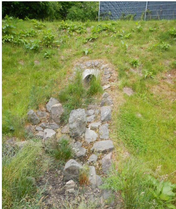
Abbildungen 61 & 62: Funktionsverlust einer Zuleitung durch fehlenden Höhengsprung und mangelhafte Unterhaltung (links); freier Rohrauslass mit Kolktschutz und Höhengsprung (rechts)
