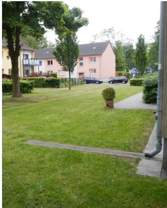
Abbildung 20: Positives Beispiel für offene Rinne mit regelmäßiger Pflege und Kontrolle des durchgehenden Gefälles
