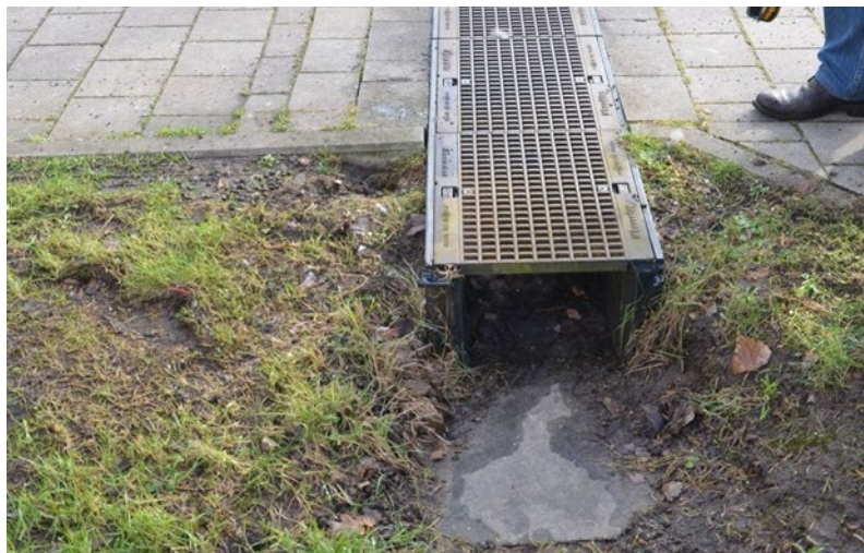
Abbildung 24 & 25: Ablagerungen auf Kastenrinne (links) und leichte Sedimentbildung in Kastenrinne (rechts) als potentieller Ausgangspunkt für Wulstbildung und Graseinwuchs
