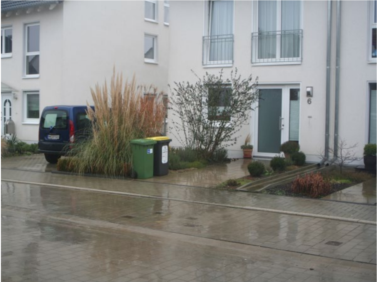
Abbildung 9: Offene Ableitung privater Dachabflüsse auf öffentliche Straße
