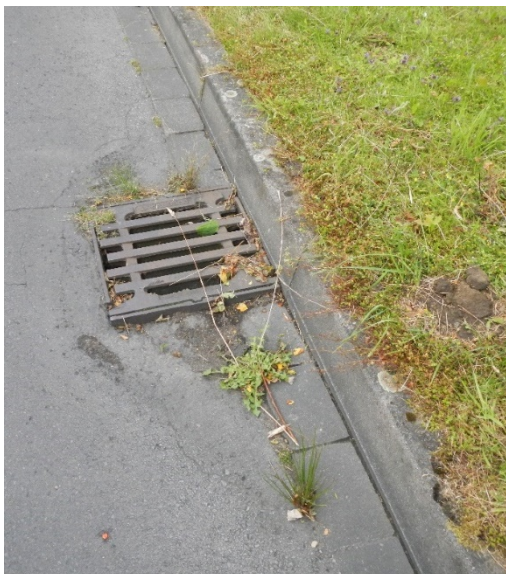
Abbildung 44: Verkrautung der Bordrinne als Folge ausbleibender Pflege sowie Absinken der Rinne gegenüber Straßenablauf
