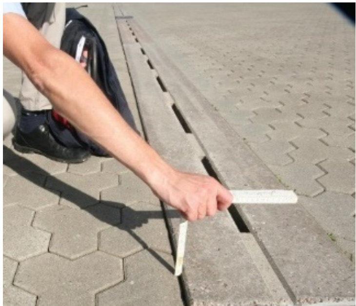
Abbildungen 34 & 35: Verkräutung einer Schlitzrinne bei unsachgemäßer Pflege des Auslaufbereichs (links) und Absenkung der angrenzenden Flächen mit Verlust der Entwässerungsfunktion und Gefahr der Pfützenbildung (rechts)
