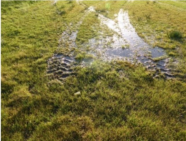
Abbildung 63: Verdichtete Fahrspuren als Ausgangspunkt für die Kol-mation der Sickersohle
