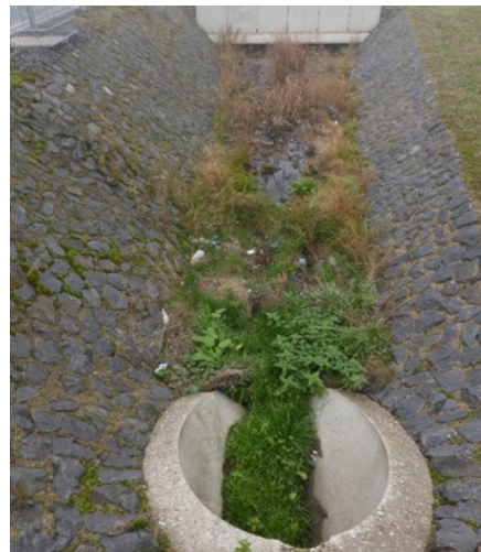
Abbildungen 36 & 37: Offener Graben als Kastenform (links). Verengung des Fließquerschnitts durch Sedimente und Grasaufwuchs (rechts)
