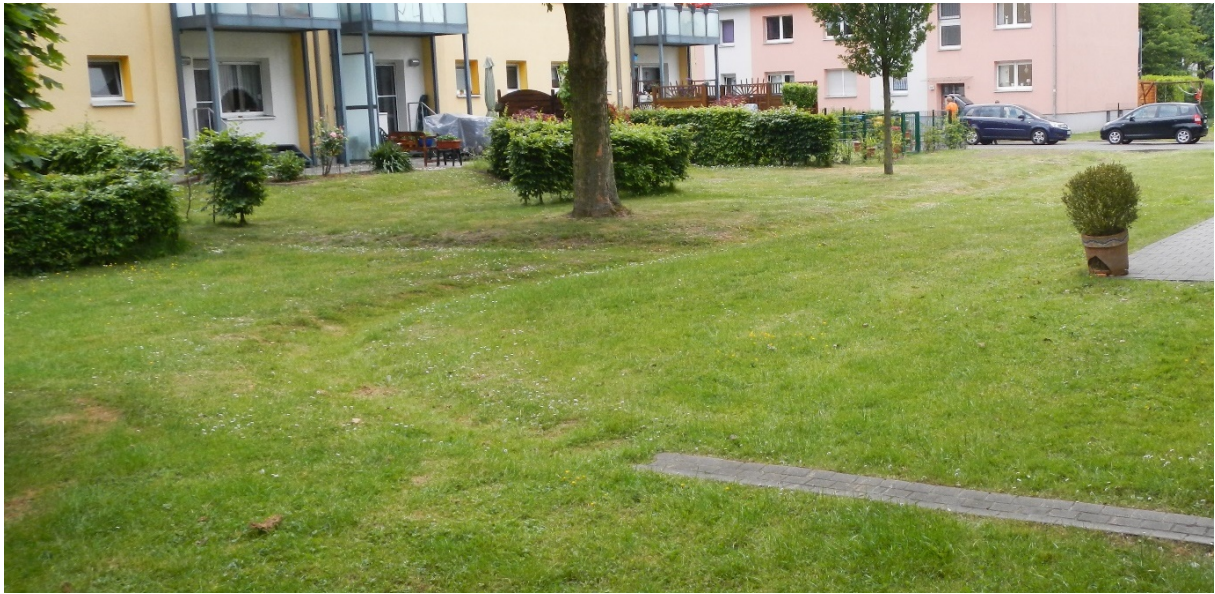
Abbildung 26: Ordnungsgemäß gepflegter Übergang von befestigter Rinne zu Rasenrinne ohne Laubablagerung, Instandhaltung der Grasnarbe und durchgehendes Fließgefälle
