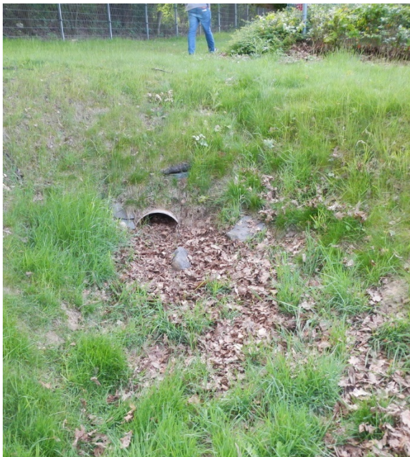
Abbildungen 61 & 62: Funktionsverlust einer Zuleitung durch fehlenden Höhengsprung und mangelhafte Unterhaltung (links); freier Rohrauslass mit Kolktschutz und Höhengsprung (rechts)
