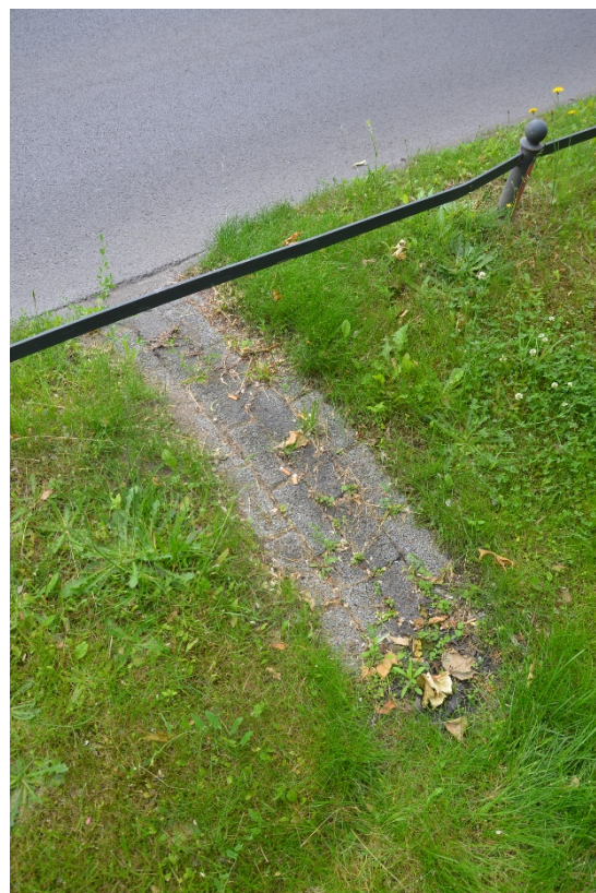
Abbildungen 55 & 56: Zulaufgrube zur Überwindung längerer Fließwege (links); Beispiel für ordnungsgemäß ausgeführte Pflasterrinne im Straßenbereich (rechts)
