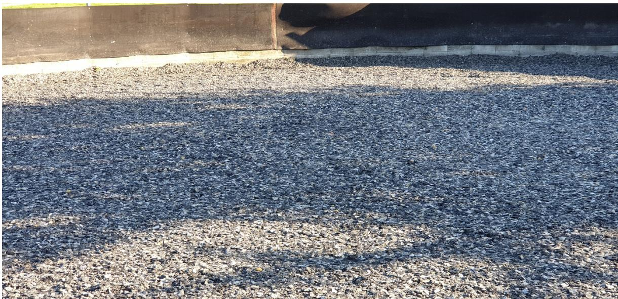
**Abbildung 2:** Vollsynthetische Tretschicht auf einem Reitplatz
