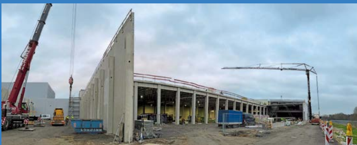
6. Bauabschnitt für Produktion und Lager
