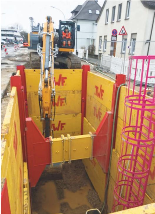
Die Vorbereitungen der 7,0 m tiefen Baugrube für die Vortriebsmaschine sind abgeschlossen. Foto: Stadt Lage
