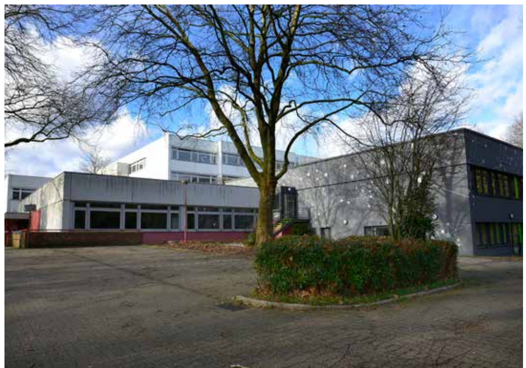
☐ Außenansicht der Hardenstein-Gesamtschule An der Wabeck.
