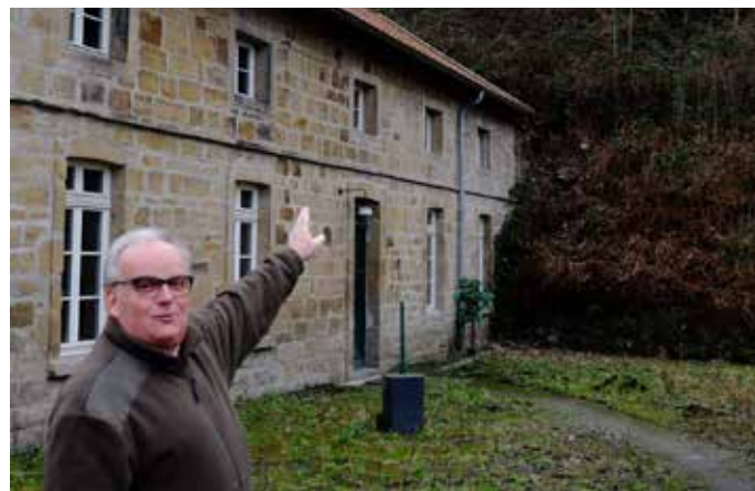
Hansjörg Frank zeigt auf den Hang, dessen Abrutschen das Gebäude bedroht.
