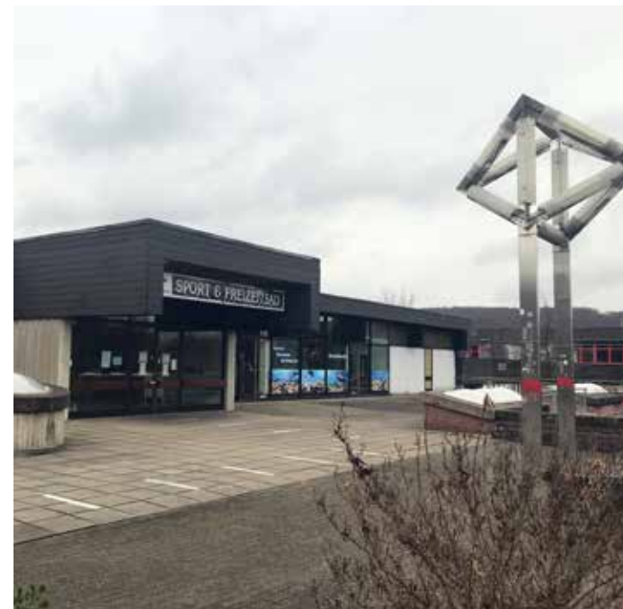
Das Hallenbad in Oberwengern ist mittlerweile geschlossen, weil nach mehreren Verschiebungen jetzt die Sanierungsarbeiten beginnen.
