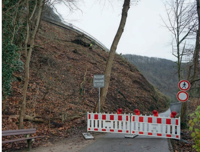
Der Ruhrtalradweg bleibt noch mindestens bis zum 31. Mai gesperrt. Es wird weitere umfangreiche Hangabsicherungen geben. Foto: Stadt Wetter (Ruhr)
