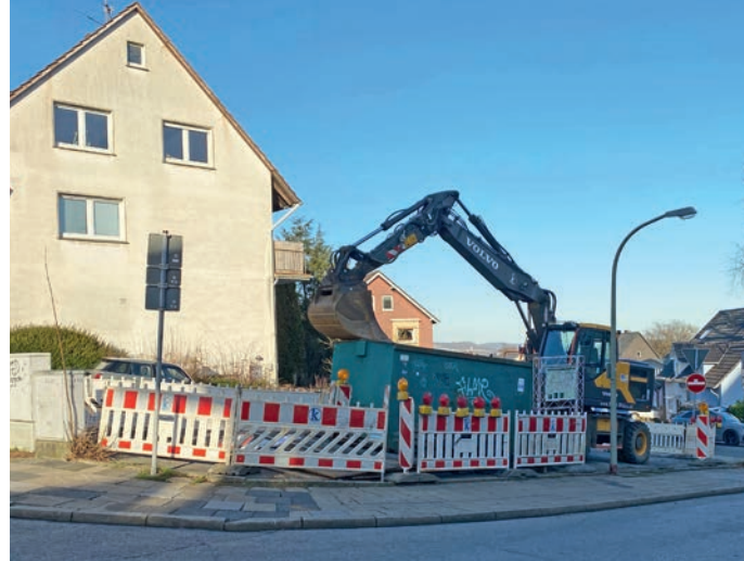
Der Bagger ist erneut angerückt: In der Heilkenstraße werden rund ein halbes Jahr lang neue Versorgungsleitungen gelegt, was Sperrungen der Straße zur Folge hat.
