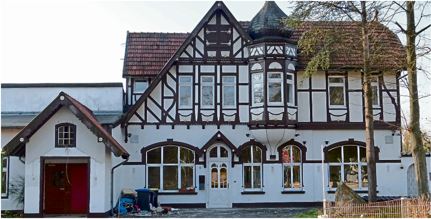
Nach umfangreichen Umbauarbeiten sollen ab Herbst im Gebäude an der B 51 Flüchtlinge einquartiert werden.
