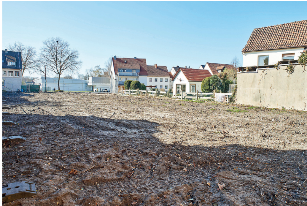
Jahrelang konnte man von der Bergstraße nicht in Richtung Gerichtsstraße schauen, weil ein dichter Wildwuchs dies verhinderte. Nach der Entfernung des Buschwerks und dem Abriss der früheren „Partystube“ ist jetzt der neue Lidl-Markt (ganz hinten) deutlich zu sehen.
