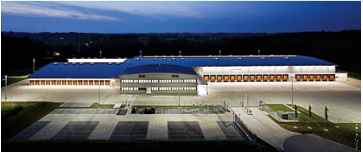
Ähnlich wie in Herford (s. o.) wird das Verteilzentrum in Hamm-Rhynern aussehen. Zusätzlich wird das Dach in Rhynern über 8.000 m 2 mit einer Photovoltaik-Anlage ausgestattet und die Energie für die Sortieranlage, die Kühlung und zukünftige Elektro-Fahrzeuge eingesetzt werden.
