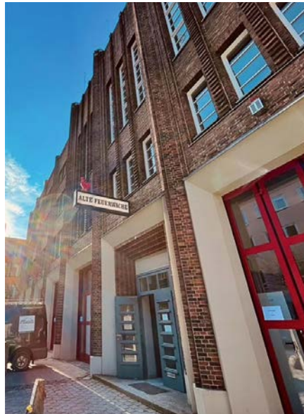
Der UpFlat-Standort in der Alten Feuerwa- che. Foto: STF
