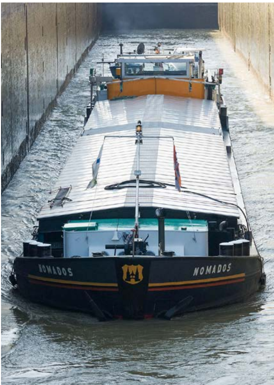
Mehrere Schleusen am Dortmund-Ems-Kanal werden gerade neu gebaut. Auch wenn es derzeit Verzögerungen gibt, sollen alle spätestens ab 2035 in Betrieb sein. Foto: IHK
