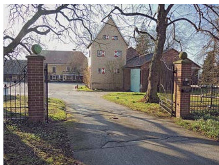
Das Haus Kotten in Böisperde
