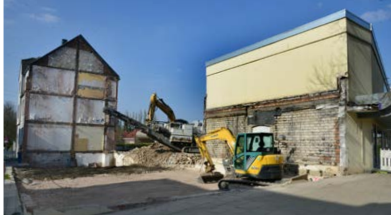
☐ Die Abrissbirne auf dem Gelände von Fischers Lagerhaus - ehemals Möbel Weber.
