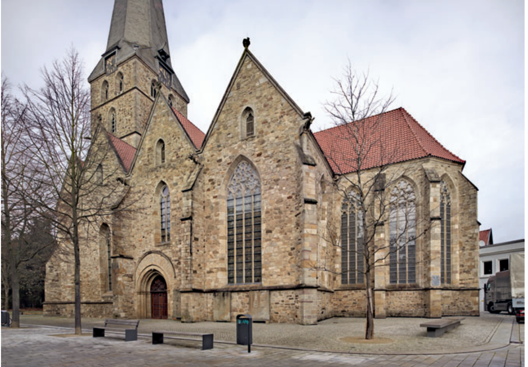
1 Herford, Neuer Markt 1, ev. Kirche St. Johannis, Außenansicht von Südosten. Fenster der Langhaussüdseite mit neuer Schutzverglasung, Chorfenster mit älterer Schutzverglasung als Bleiverglasung mit Spitzrauten. Foto 2021.
