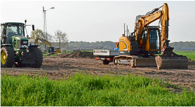
Größere Erdbewegungen finden derzeit im Telgter Süden statt. Dabei handelt es sich um vorbereitende Arbeiten für das Neubaugebiet im Telgter Süden. Foto: Andreas Große Hüttmann
