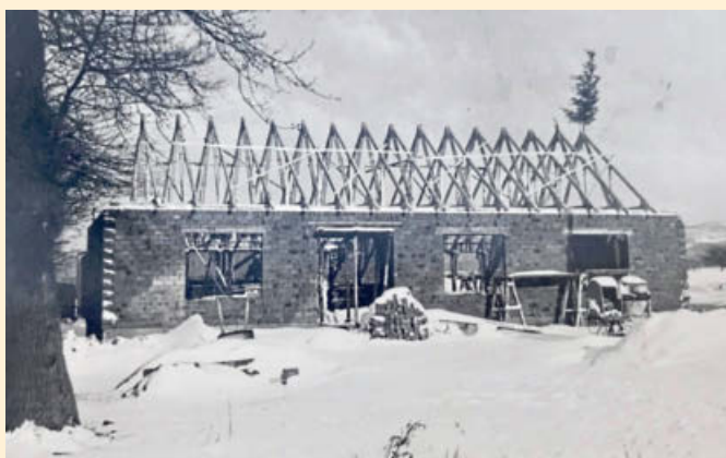
Hier der Neubau des Schützenhauses im Jahr 1967. Am 14. Dezember fand das Richtfest statt. Repro: Anke Schneider
