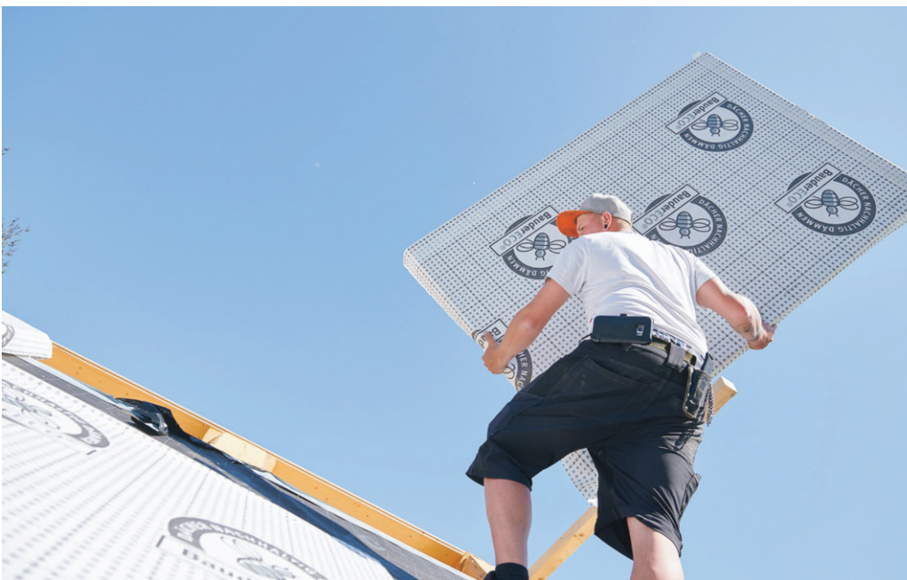
Eine ohnehin geplante Dachverschönerung ist der passende Zeitpunkt, um mit einer zusätzlichen Dämmschicht dauerhaft Energie zu sparen. Foto: djd/Paul Bauder/Michael Gallner
