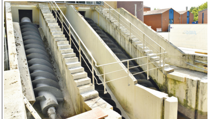
Die archimedische Schraube wird heute noch zur Wasserförderung eingesetzt. Fotos: rp
