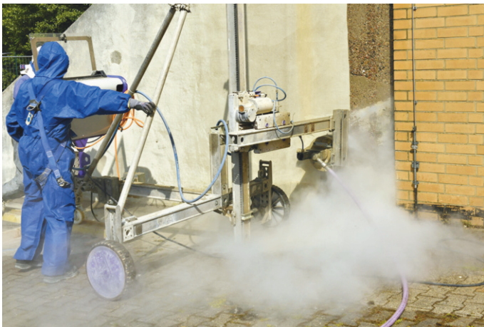
Über 2.000 bar Wasserdruck machen sogar dem Beton den Garaus. Fotos: rp
