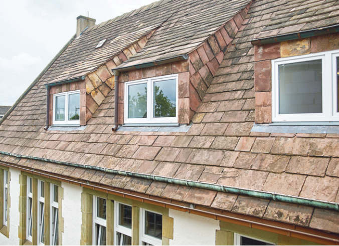
In das Gemeindehaus wurden auf der Westseite neue Schleppgauben eingebaut. Es ist kein Unterschied erkennbar zu den auf der Kirchenseite bereits vorhandenen Gauben.
