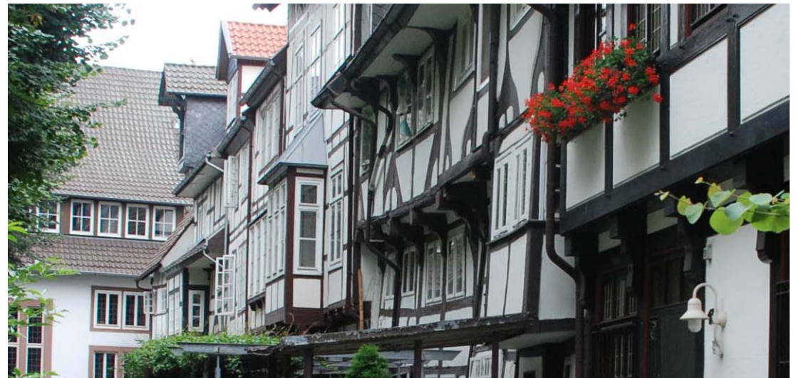
Rückwärtige Fassaden Mittelstraße
