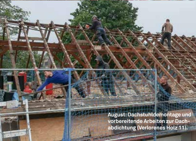
August: Dachstuhldemontage und vorbereitende Arbeiten zur Dachabdichtung (Verlorenes Holz 11).
