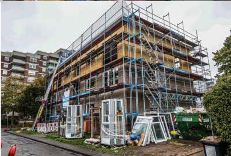
September/Oktober: Der Dachaufbau am Haus Verlorenes Holz 11 ist bis auf das Aufbringen der Dachsparren fast fertiggestellt.
