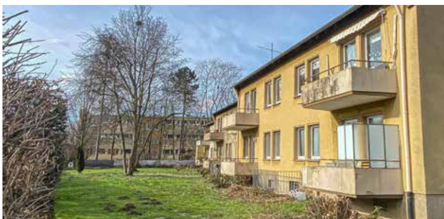
Durch die DG-Aufstockung der Häuser in Renninghausen entstehen sechs neue Wohnungen.
