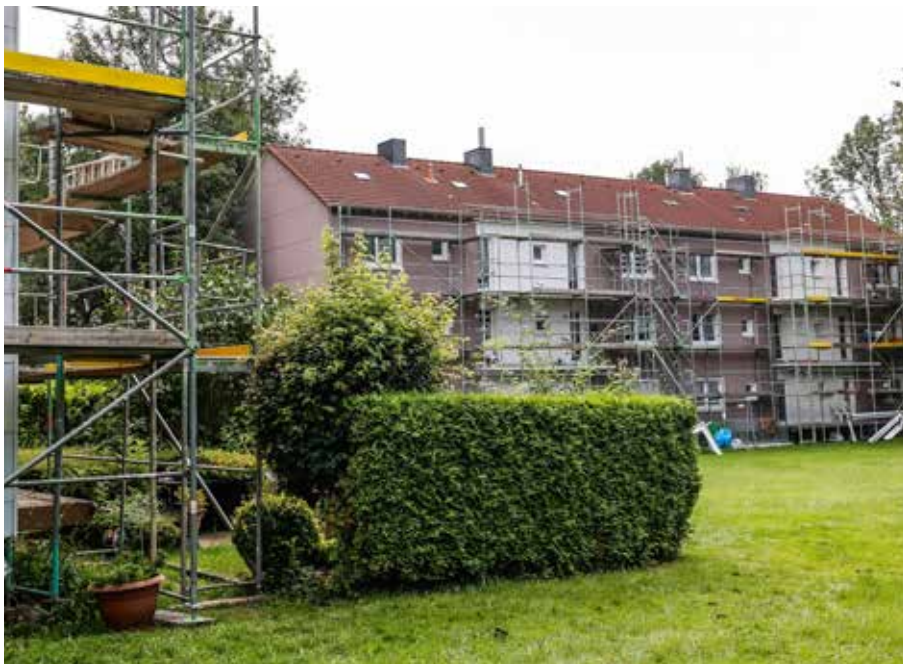
Sechs Wohnhäuser umfasst der erste Bauabschnitt.
