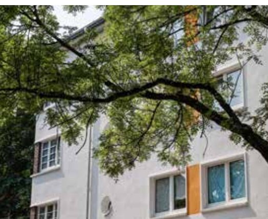
Neuer Charme: fertiggestellte Häuser in der Kleine Herderstraße.
