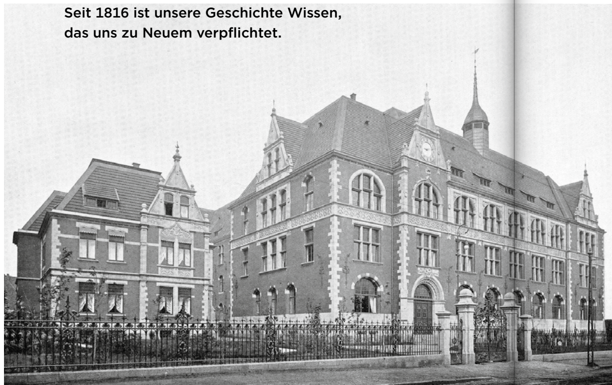
Das „neue“ Hochschulgebäude an der Herner Straße um 1900.
