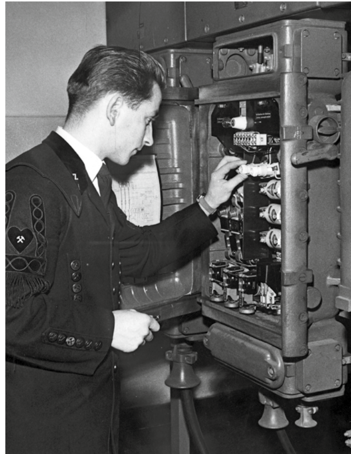
Faszination E-Technik in den 50ern: Der Bergschüler eines Elektrosteiger-Lehrgangs prüft einen schlagwettergeschützten Schalter.
