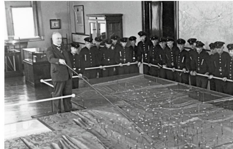
Markscheiderei am Mintrop-Modell: Im Maßstab von 1:10.000 lernen die angehenden Fachkräfte die Steinkohlenablagerung im rheinisch-westfälischen Revier kennen.
