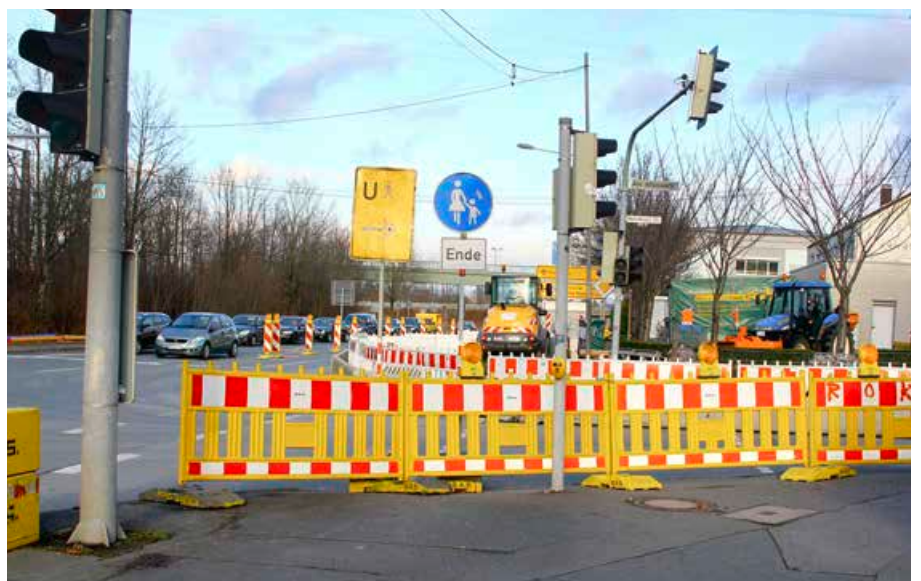
Was sein muss, muss sein: Nötige Sanierungsarbeiten führen fast immer zu Straßenbaustellen.
