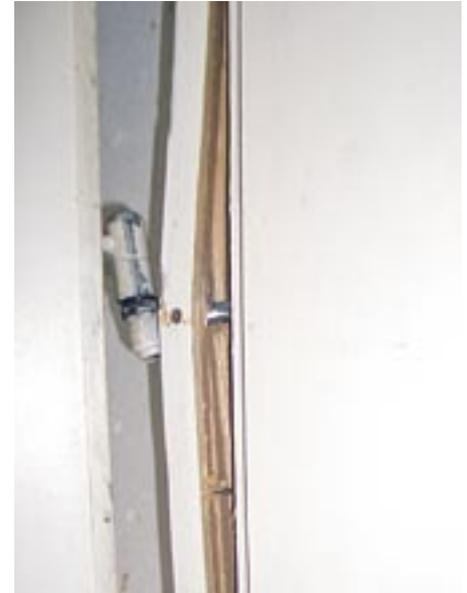
Auch ein Fall für die Haftpflichtversicherung: Eine herausgebrochene Türzarge
