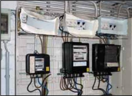
Überspannungsschäden lassen die Sicherungskästen verschmoren.
