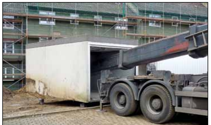
Versetzen der Fertiggaragen.
