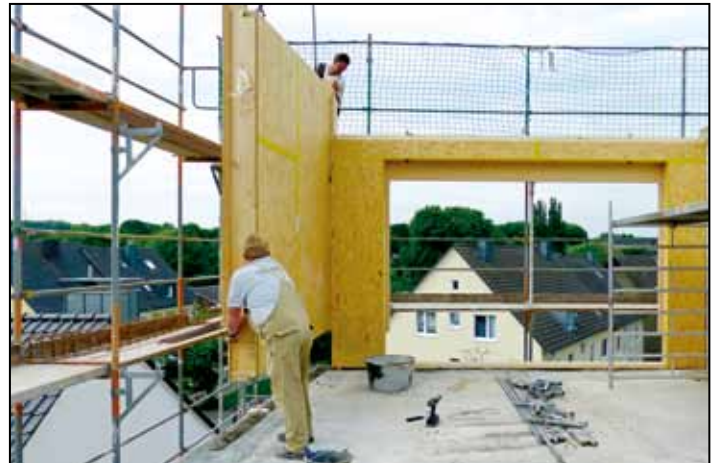
Außenwände im Holzrahmenbau.
