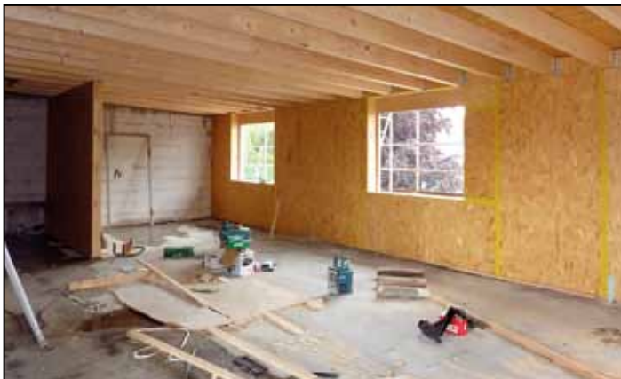
Die Aufstockung im Rohbau.
