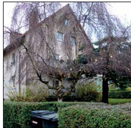
Balkon und Innenräume bekommen kaum noch Licht.
