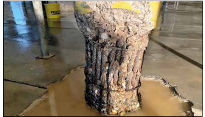
Korrodierte Bewehrung
