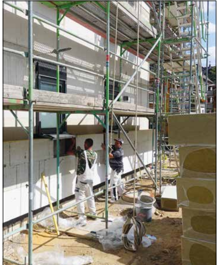
28 cm Mineralwolle auf der Außenwand als Wärmeisolierung.
