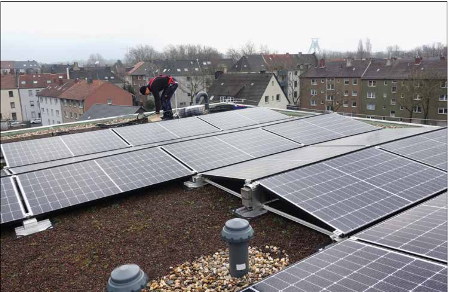
Montage der Photovoltaikanlage
