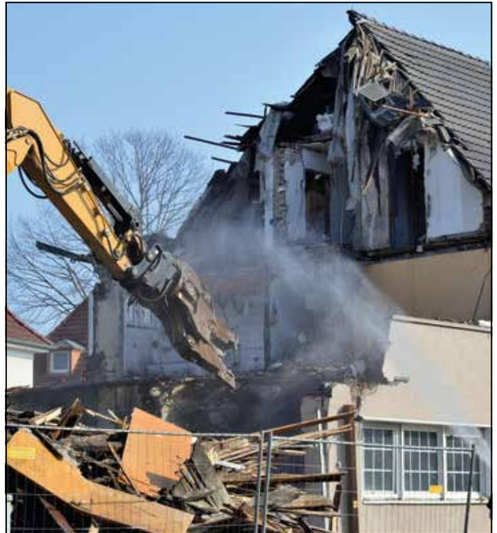
Die hydraulische Abbruchscherer trennt harte Betondecken auf.
