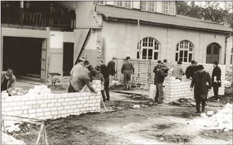
1967 bekommt unser Schützenhaus auch einen neuen Haupteingang.
