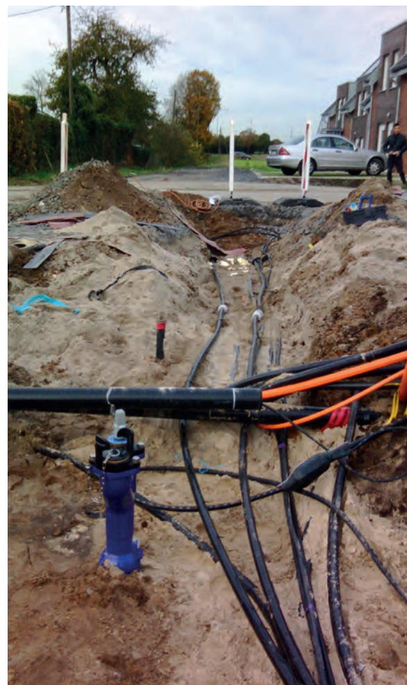
Baustelle im Rheder Norden
