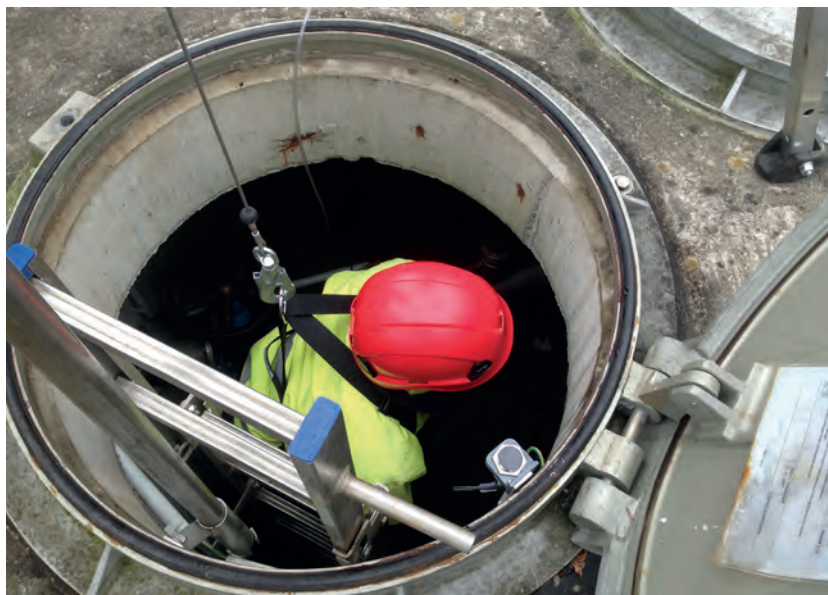
Rettungsübung im Brunnenschacht
