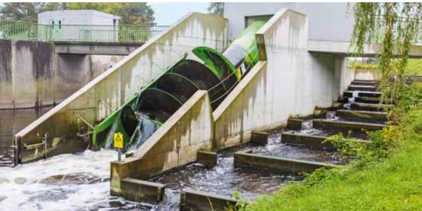
Die Schraubenschnecke nutzt die Schwerkraft des Wassers.
