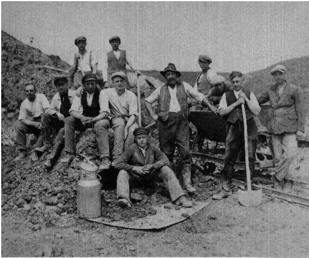
Während der Bauzeit des Jahn-Stadions im Jahr 1932 stellten sich nicht nur die Turner, sondern auch viele Arbeitslose für die Arbeiten zur Verfügung
