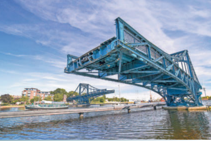
Die Kaiser-Wilhelm-Brücke - Europas größte Drehbrücke
