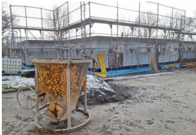
Der Rohbau des neuen Kindergartenbaus begann Mitte Oktober 2020, bereits im Januar 2021 war dieser fertig. Foto: Vahle
