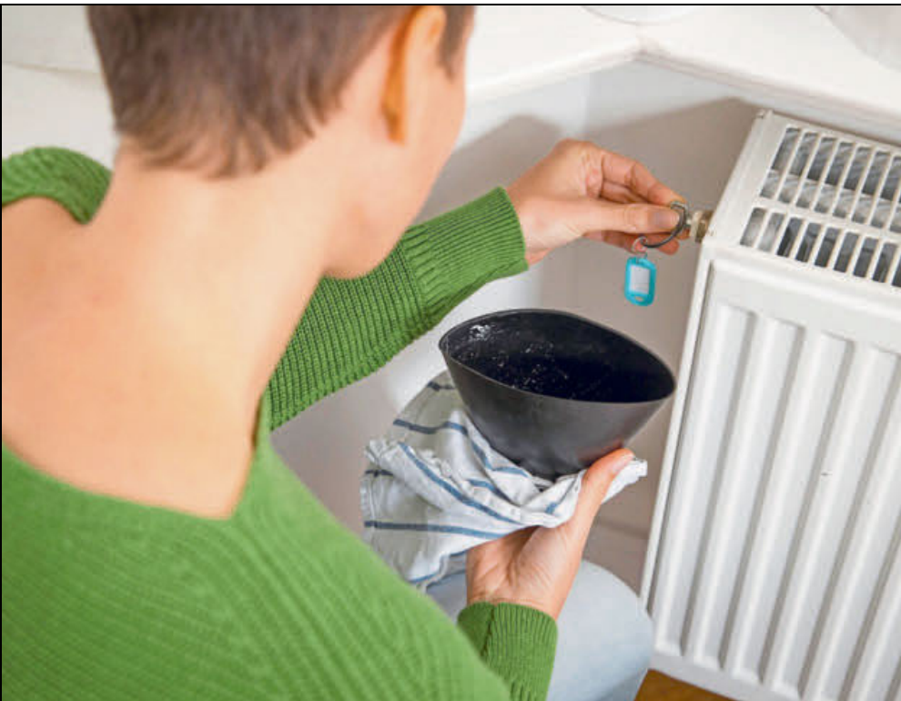
Luft raus: Das Entlüften der Heizkörper kann beim Heizkostensparen helfen. Foto: avs
