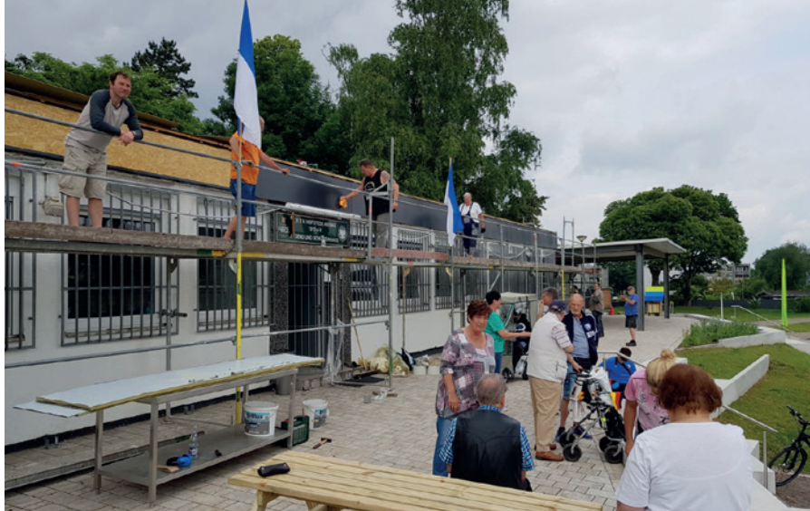
Arbeiten am Schützenhaus im Rahmen der Sanierung
